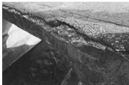
橋の現状①
